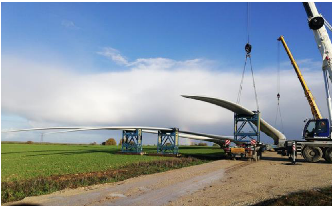
Figure 54 : Stockage des pâles durant le chantier
